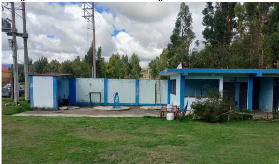
Imagen N° 14: Planta de Tratamiento de Aguas Residuales – Localidad Orcotuna
