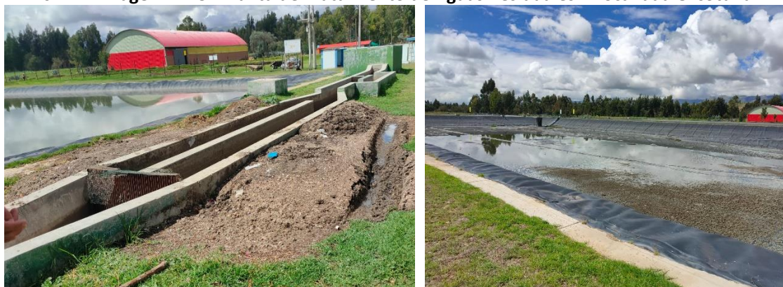
101. Imagen N° 15: Planta de Tratamiento de Aguas Residuales – Localidad Orcotuna
