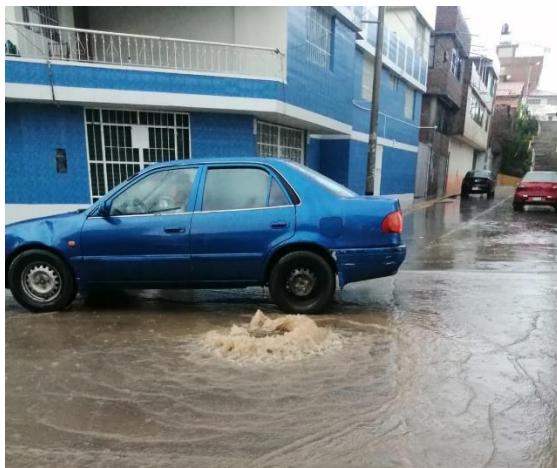
Imagen N° 8: Buzón rebalsado durante lluvias – Localidad Huancayo
