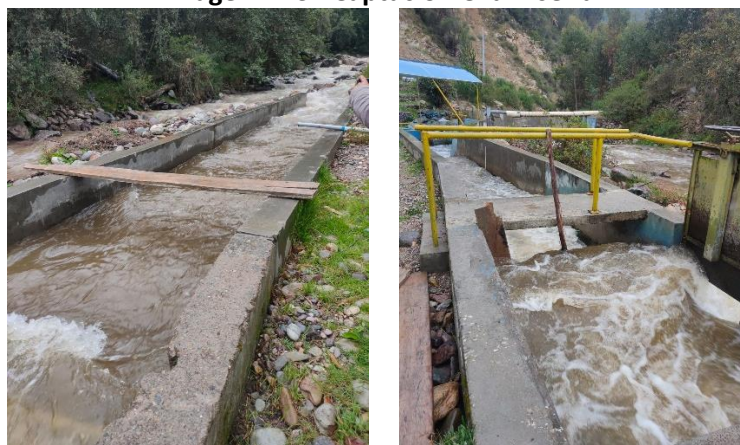
Canal de Captación Chamisería
