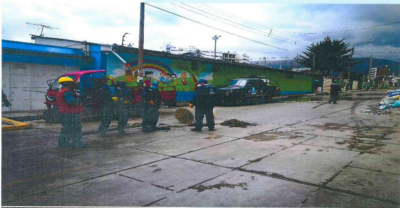
Imagen: Desatoro de redes de alcantarillado sanitario con el grupo de varilleros
